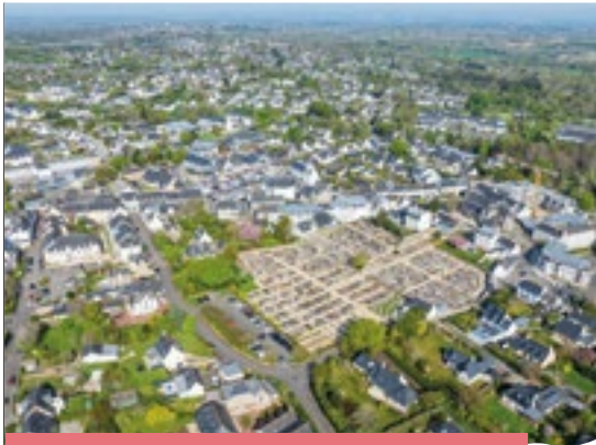
AMÉNAGEMENT DU CIMETIÈRE
