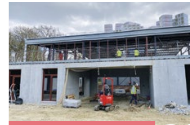
EN COURS DE CONSTRUCTION
