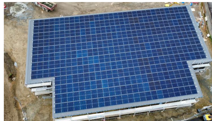
Hangar des ateliers municipaux dédiés équipé de panneaux photovoltaïques (Mairie de Fouesnant)
