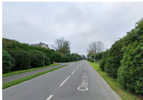
10- Arrivée au Sud du Centre-ville via la route de Beg-Meil (RD 45). L'urbanisation (habitations et équipements) est masquée d'importantes haies de part et d'autre de la voirie.
