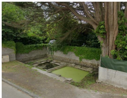
Lavoir chemin de Kernoac'h (Source : Google Maps)
