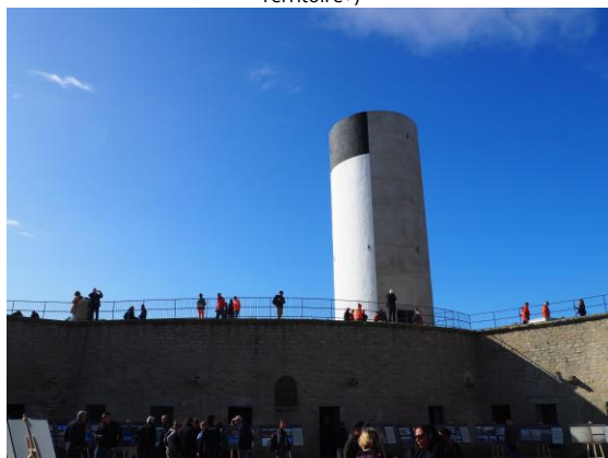
Tour rénovée du Fort Cigogne (Source : Territoire+)
