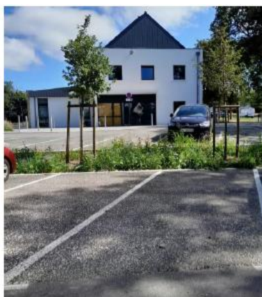
Noue avec tranchée d'infiltration
