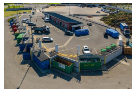
Déchetterie de Kerambris (Source : CCPF)
