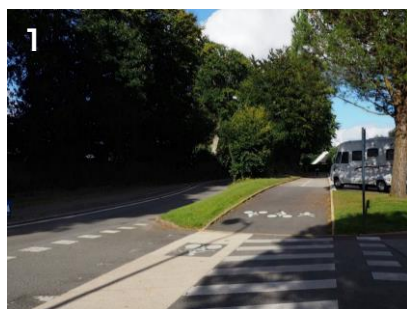
1 Aménagement cyclable allée de Loc-Hilaire (Source : Territoire +)
